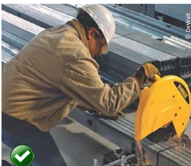
Fig. Resguardos de la esmeriladora para la protección frente a proyecciones en la zona de esmerilado, y empleo de equipos de protección individual.
