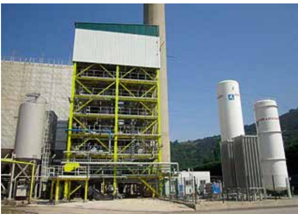
Central térmica de La Pereda.
